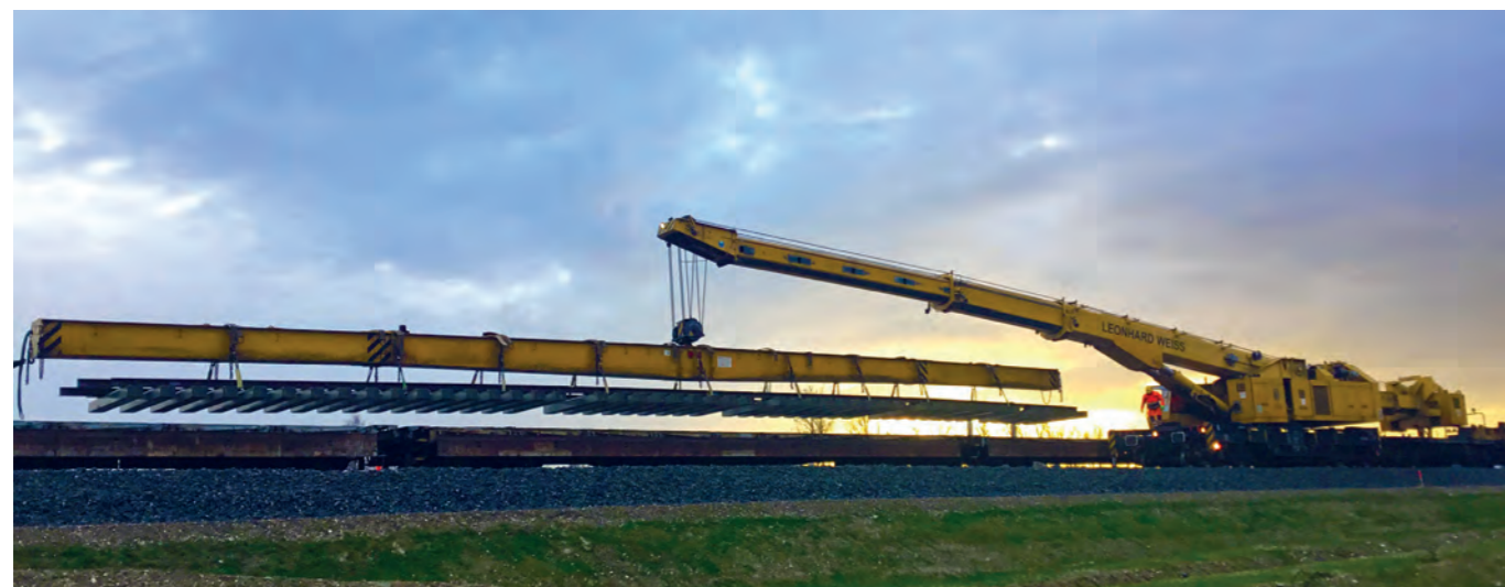
Zabudowa rozjazdu Rz 60E1 – 2500-1:26,5
